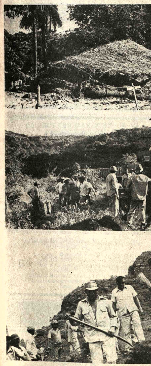
TRABAJO.- La Empresa Nacional de Ferrocarriles ha dispuesto la movilización de técnicos, maquinarias, equipos y trabajadores para habilitar el tránsito en la vía férrea. Una Cruz Curupaí, una camioneta destruida por efecto de la mazamorra. La Cruz señala el lugar donde fue sepultada una familia diego ocupante de la choza. La foto del centro permite observar los tractores desahogados desde un convoy ferroviario para rehabilitar la zona. La fotografía inferior muestra a las cuadrillas de obreros en sus trabajos de rehabilitación de la línea. (Foto Horacio Alcazar para PRESENCIA).
