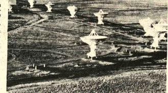
POTENCIA. - Very Large Array (VLA), descrito como el radiotelescopio más potente y sensible del mundo, se construye en un lugar remoto del desierto de Nuevo México. Las 27 gigantes antenas, formadas en una Y, rodean un mayor número de ondas de radio del espacio y discriminan entre ellas con mayor precisión que los medios ahora usados. Los brazos de la Y tienen 21 y 19 kilómetros de extensión. Estará terminada antes de 1981.
