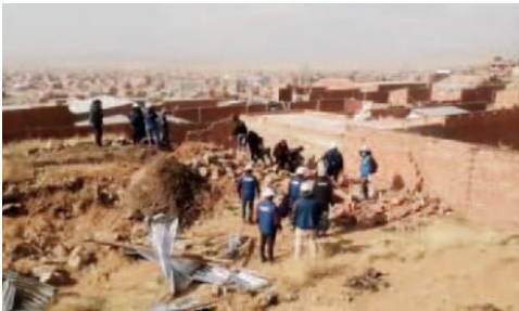
El operativo culminó con las 4 viviendas ilegales demolidas / GAMO
