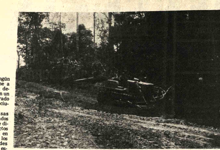
INSPECCION.- El Comandante de Ingeniería del Ejército inspeccionó los trabajos del camino Cobija - Puerto Hech, que alcanzaron al río Manuripi. La foto muestra los trabajos que se realizan en ese lugar.
