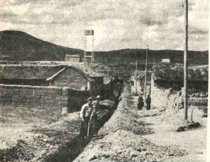
CARACOLLO. CORPAGUAS ejecuta los trabajos del sistema de agua potable para la población de Caracollo, en el foto vemos las excavaciones de zanjas para tendido de la tubería, al fondo el tanque elevado con capacidad de 24 mil litros. (Foto BETO para PRESENCIA).
