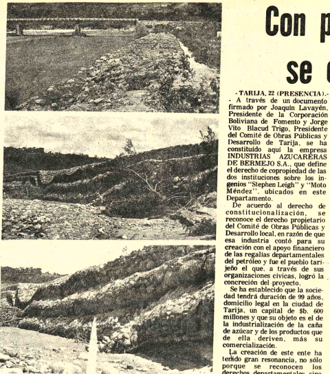
DESTRUYOS. La composición muestra tres aspectos de los destruyos ocasionados por la riada en los defensivos del puente Tarumá, sobre la carretera Cochabamba - Santa Cruz. FISNC comenzó la reparación (Foto FRANCO para PRESENCIA).
