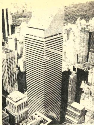
**RASCACIELOS ANGULAR:** El Citicorp Center, con su singular techo angular que contiene un bloque de concreto de 400 toneladas, que es móvil, es el único edificio nuevo de gran tamaño que se terminará en la ciudad de Nueva York en 1977. El bloque fue proyectado con el propósito de reducir la perturbación por los ocupantes del balance que producen los vientos fuertes. (USIS)
