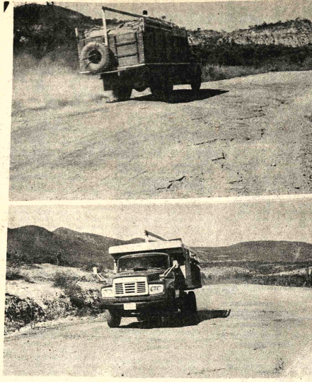
CAMINO DETERIORADO. El camino carretero Santa Cruz-Cochabamba se encuentra muy deteriorado...
