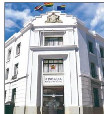
Edificio de la Fiscalía en Sucre.
