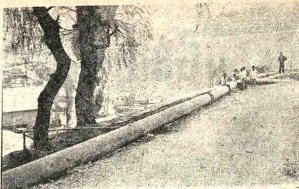
AGUA PARA LA PALCA. - Se ha instalado una tubería que suministra el agua necesaria para los trabajos de instalación de la planta de volatilización en La Palca. (Foto MENDOZA para PRESENCIA).
