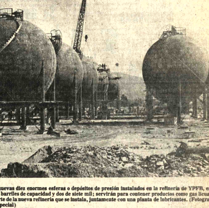
AMPLIACION. Parte de las nuevas diez enormes esteras o depósitos de presión instalados en la refinería de YPF...
