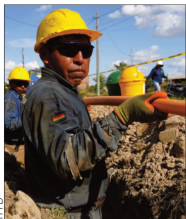
Obreros trabajan en instalaciones.
