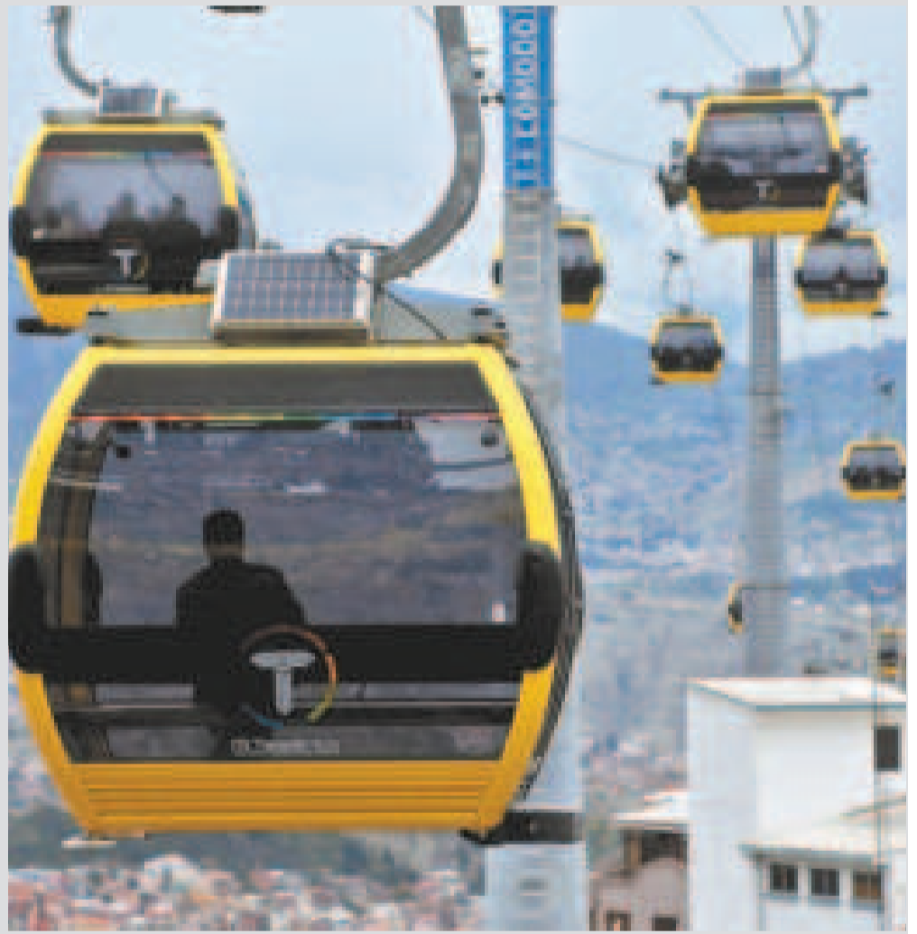
La Línea Amarilla con su estación en la Curva de Holguín de la zona de Obrajes, que llega hasta la estación en la zona Satélite, en la ciudad de El Alto.
