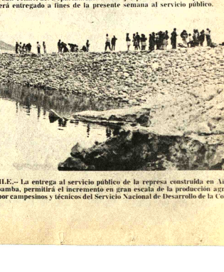
REPRESENTA EN AGUILA. La entrega al servicio público de la represa construida en Aguila, Departamento de Cochabamba, permitirá el incremento en gran escala de la producción agrícola. Esta obra fue construida por campesinos y técnicos del Servicio Nacional de Desarrollo de la Comunidad y que será entregada a fines de la presente semana al servicio público.
