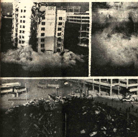
SECUENCIA.- Miami, Fla, 28 (AP). - El panes muestra la secuencia del derrumbe del edificio médico Seaboard en Miami. Comienza a desmoronarse al estallar los explosivos. Contina desmoronándose a lo largo, cuando una nube de polvo se eleva, sólo queda una pila de escombros. (Radiofoto AP).
