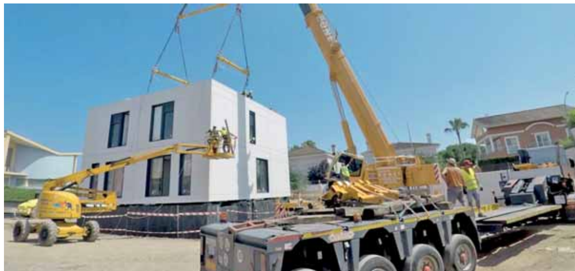
La construcción fuera de obra, también conocida como construcción modular o prefabricada.
