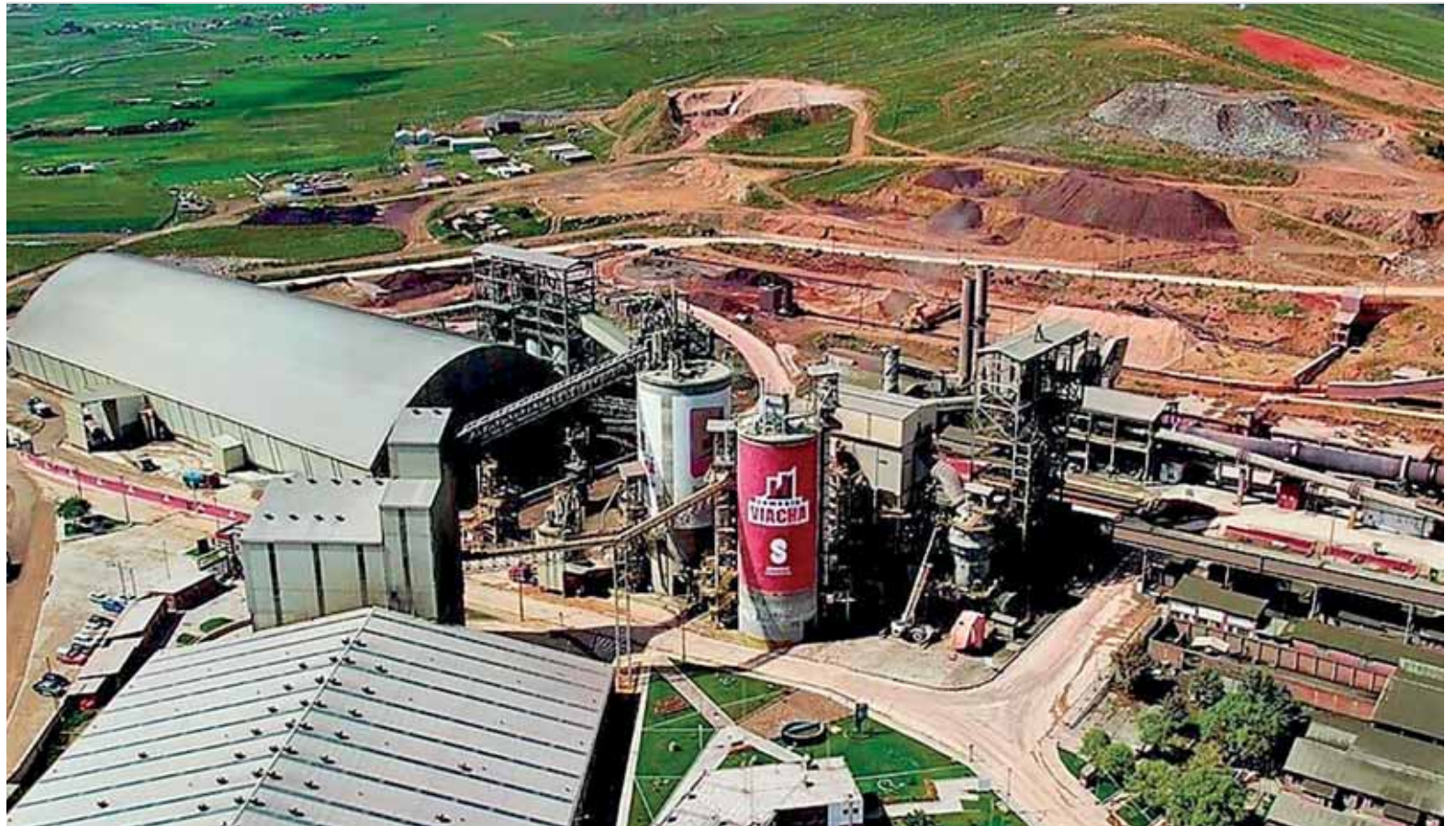
Soboce cuenta con 3 plantas con una capacidad instalada para producir más de 3,3 millones de toneladas de cemento al año.
