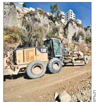
La obra está al 45% de avance.
