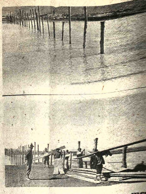
DEFENSIVOS. Postes de madera plantados en medio del río Desaguadero, para construir defensas que eviten su desborde sobre Oruro. (Abajo) Campesinos trabajan en el reencauceamiento del Desaguadero, en la región de Ecucliptus - Soledad. En la obra cooperan CORDEOR, SENAC y el Reg. "Camacho".
