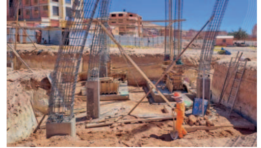
Avanza construcción del nosocomio de segundo nivel /GAMO
