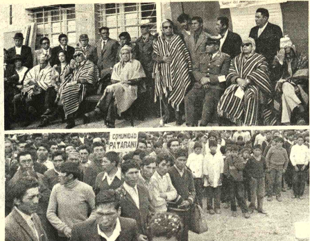
-SE ENLOSETAN CALLES DEL PUEBLO DEL DESAGUADERO.- Con el propósito de contribuir al desarrollo de la localidad fronteriza del Desaguadero, la Prefectura del Departamento Incaicé, en breve, el entosado de las arterias de esa población. El anuncio fue hecho durante la visita que efectuó el Prefecto a esa población, quien fue acompañado por el Ministro de Educación, Teni Waldo Bernal Perera. El Prefecto Escobar, en su discurso, agradeció al titular de Educación por la donación de papeles y material didáctico a las escuelas rurales del Departamento. El anuncio hecho sobre el entosado fue recibido con alborozo por las autoridades y los pobladores del Desaguadero. El Prefecto señaló que hasta mediados del próximo mes hará llegar la enlosetadora, para que con el concurso de los pobladores sea una realidad el mejoramiento del Desaguadero. El Alcalde del Desaguadero agradeció a las autoridades visitantes, quienes fueron posteriormente declarados "hospedes literas" de esa población.
