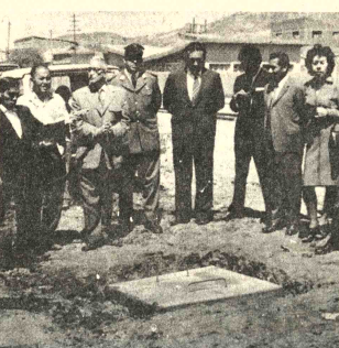
AMPLIACION. El Alcalde de Oruro, Enrique Miralles, libro al servicio público la ampliación del servicio de alcantarillado en la Av. 8 de Agosto, obra realizada con el concurso de los vecinos de la zona.
