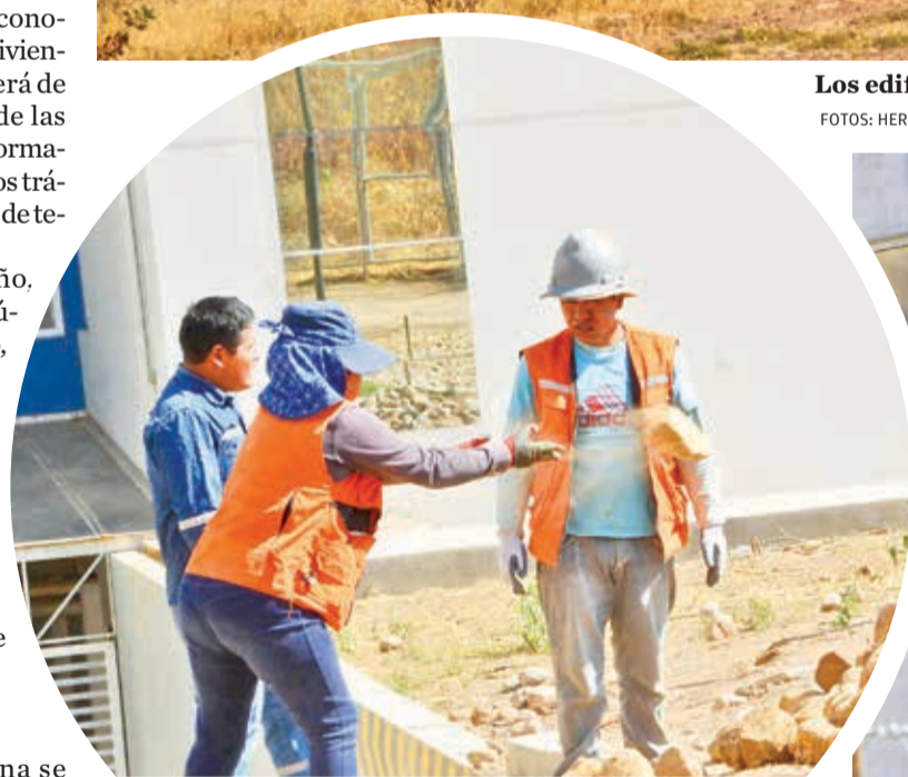
Trabajadores reparan uno de los garajes de la villa.
