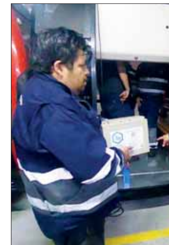
Colocan baterías en la cabina.
