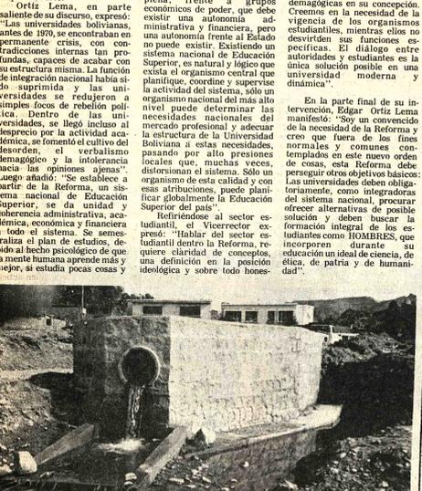
ALCANTARILLADO.- En Segñecoma, Calacoto e Irapvi se realizan trabajos de instalación de alcantarillado, que se encuentran en su etapa final. La fotografía ilustra una de las cámaras de descarga del doble alcantarillado, pluvial y sanitario, que construye la Municipalidad a un costo total de más de 500 mil pesos bolivianos.
