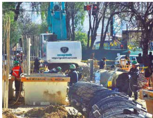
La construcción del distribuidor de la av. Perú. JOSÉ ROCHA
