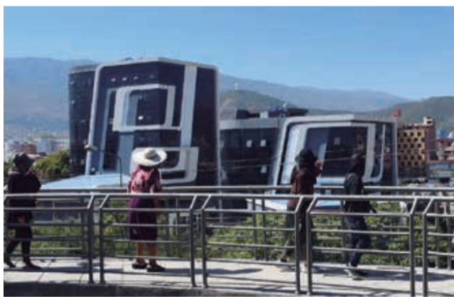
El edificio de la Gobernación de Cochabamba. CARLOS LÓPEZ
