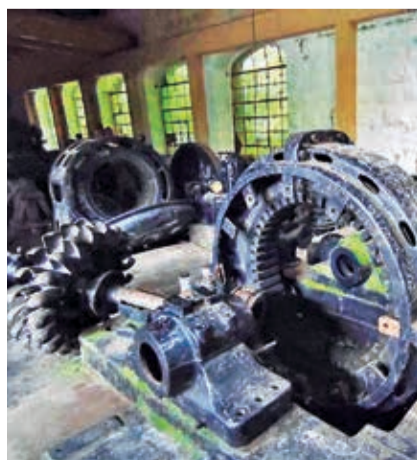
La antigua Casa de Máquinas.
