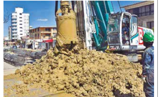
Los trabajos en el distribuidor de la av. Perú. CARLOS LÓPEZ
