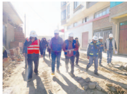
Autoridades visitaron obras ediles que están en ejecución /LA PATRIA
