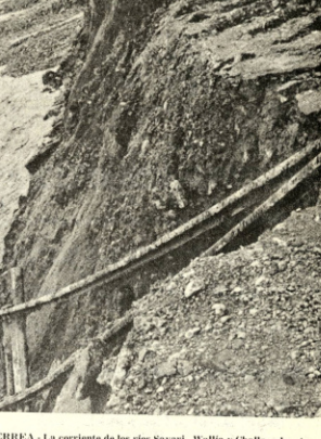
DESTRUCCION DE VIA FERREA. La corriente de los ríos Sarari, Walla y Challa, además de las mazorras, provocaron la casi total destrucción del tendido ferroviario entre Aguas y Cochabamba. Las pérdidas llegan al millón de dólares. El tráfico estará interrumpido por días de un mes.
