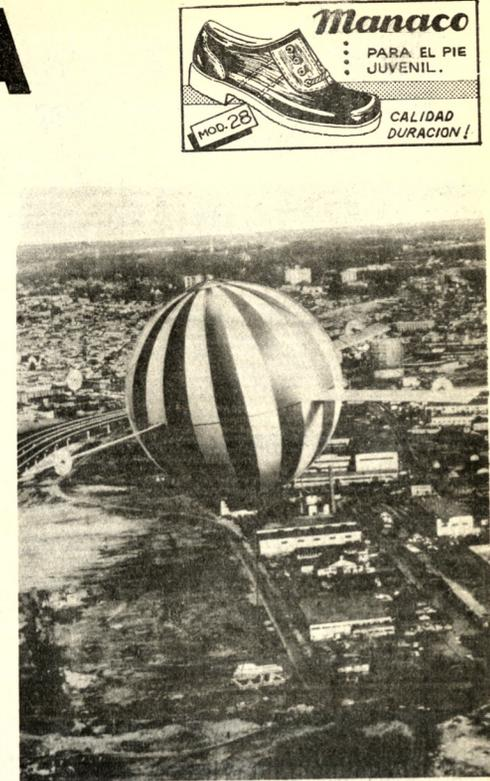
GLOBO HELICOPTERO. Una nueva dimensión del transporte en serie se muestra en esta fotografía compuesta de un "Aerocar" o sea un globo-helicóptero que se eleva mediante combustible de helio y helios rotatorio. Un pequeño modelo de esta nave se está sometiendo a pruebas de vuelo en la compañía American Engineering, de Wilmington, Delaware. Versiones grandes de esta nave podrían transportar hasta 500 toneladas a velocidades de más de 5 kilómetros por hora.
