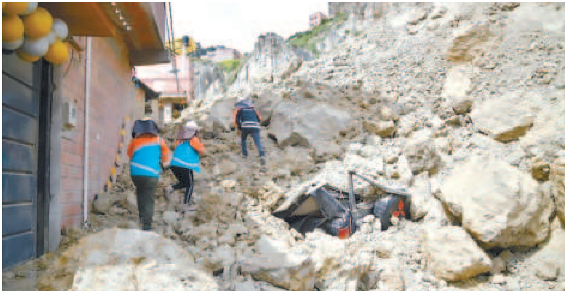
Una de las zonas afectadas por los derrumbes en la época de lluvias en La Paz.
