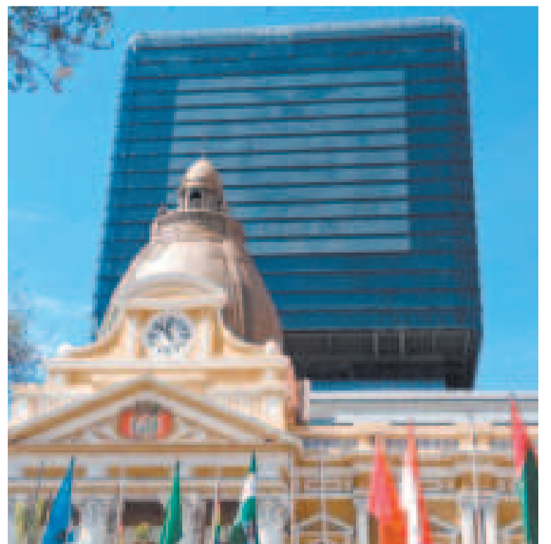
Frontis del antiguo edificio de la Asamblea Legislativa. Detrás está el nuevo.
