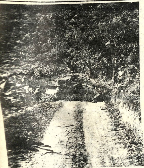
Central Parajes. CARANAVI: Se construye una carretera vecinal que permitirá la comercialización de varios productos agrícolas a los mercados de La Paz.
