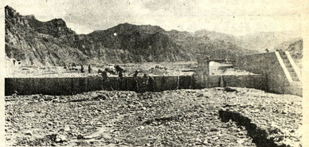
La Comuna paceña construye defensivos en la región de Achumani, al sur de la ciudad, donde se construirá una moderna urbanización proyectada para la vivienda de importantes sectores de la ciudadanía.
