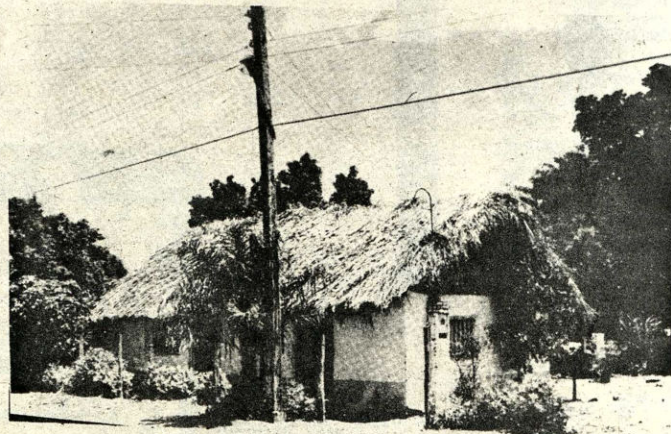
Una modesta vivienda ya cuenta con servicio eléctrico.
