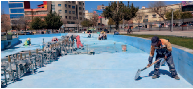
Trabajos en la plaza Sebastián Pagador / LA PATRIA
