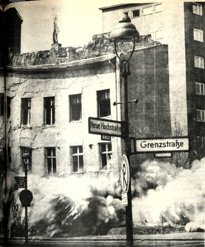
-Explosión para demoler una vieja vivienda en el distrito Wedding de Berlín, Alemania. Aquí hay 16 mil apartamentos que necesitan renovación en un área aproximada de 1.856 ha. Hasta ahora se han derribado 3.190 edificios bajo el programa de renovación de la ciudad.
