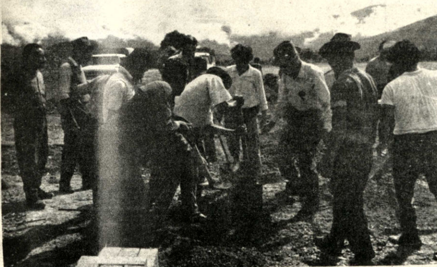
Así se iniciaron los trabajos en el colegio secundario de la localidad yungueña de Coripata cuya conclusión se efectuó en la víspera.
