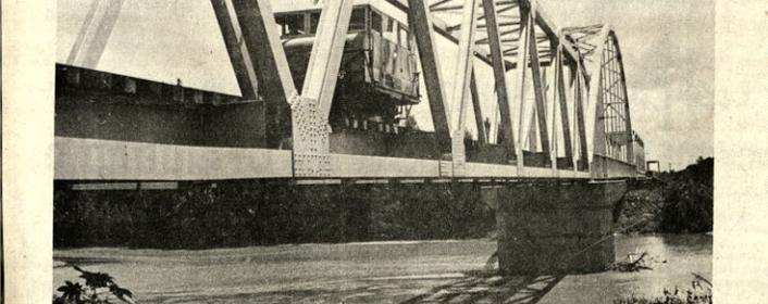
Puente metálico, semiparabólico, de 165 m. luz, sobre el río Piraf, en el km. 604, del primer sector Santa Cruz-Santa Rosa.
