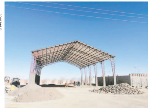
Planta de Prefabricados de Hormigón se encuentra en Moxuma /LA PATRIA ARCHIVO
