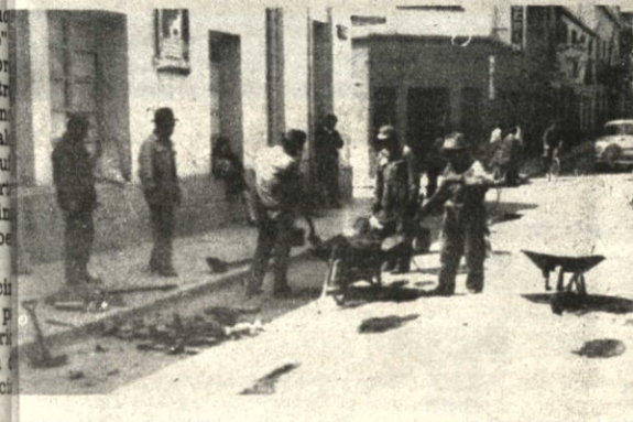
-Cuadrillas especiales de trabajadores de la Comuna estuvieron activos en los últimos días con el arreglo de la principal arteria de ingreso de la fastuosa fiesta carnavalesca, la Av. Pagador.
