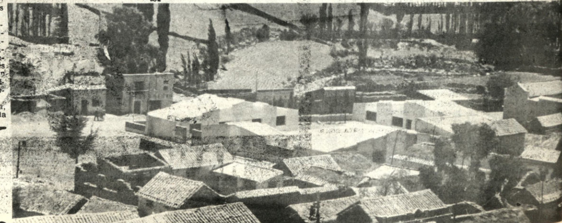
Rodeada de viviendas campesinas se alza una moderna edificación en Villa Yocalla (Potosí). Se trata de una escuela construida bajo el régimen de auto-ayuda por el Servicio de Desarrollo de la Comunidad y los trabajadores del campo.
