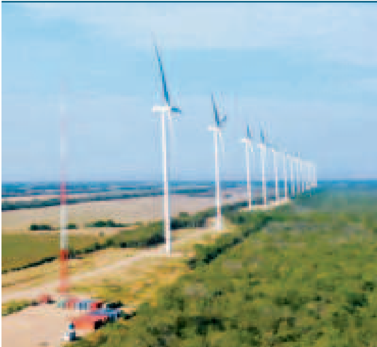
Las infraestructuras para la generación de energía eólica.
