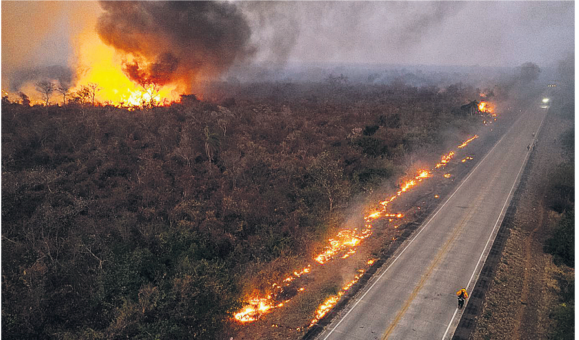
El fuego se expande sobre los bordes de la carretera Bioceánica, donde hay horarios que es imposible transitar debido a la densa humareda y el peligro de las llamas
