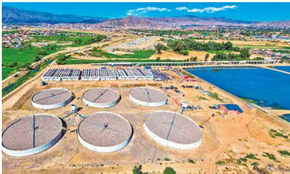
La nueva planta de tratamiento de aguas servidas de Albarrancho. GAMC
