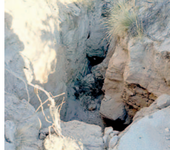
Pobladores de Turco denuncian que la grieta se abrió más este año /PADRE CALIXTO MAMANI
