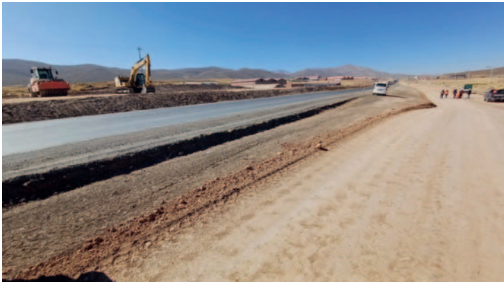
Se estima que la obra será concluida a finales de 2025 / JORGE HUJANCA
