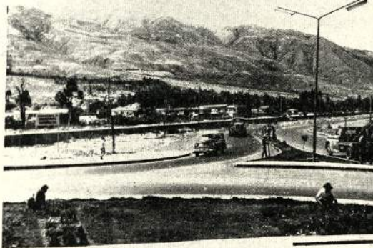
-El río Rocha, entre los puentes de Cala-Cala y Tupuraya no cuenta con muros de coronamiento y protección. Una de las carpetas—proyecto preparadas por el Municipio otorga carácter de prioridad, por la sucesión de graves accidentes que se registran en zonas de intensa circulación de vehículos
