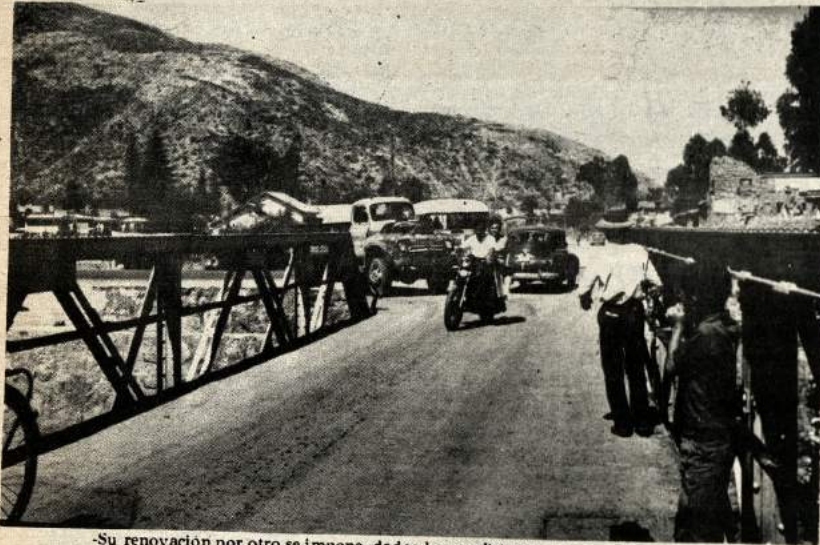
-Su renovación por otro se impone, dadas las condiciones de estrecheces y su estado de abandono en que se encuentra. Afecta a las zonas de Tupuraya y Muyurina, en las que se concentran varias unidades escolares.
