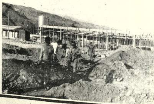
Planta Beneficiadora de Asbesto COCHABAMBA
