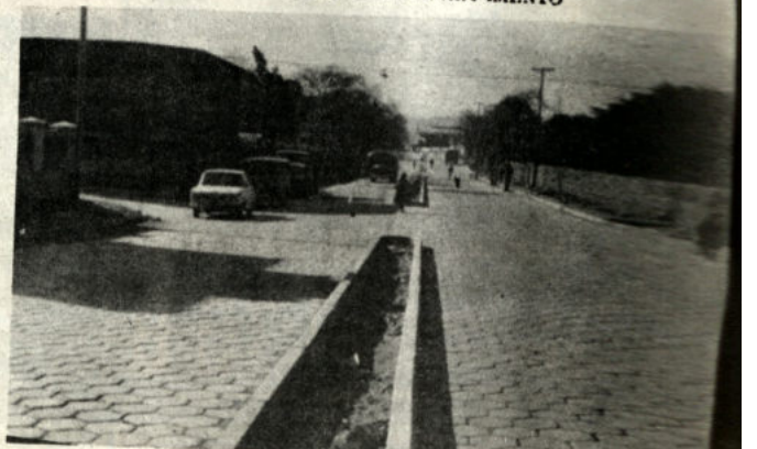
Entrecada de la Avenida España en su fase de construcción gracias a la gestión positiva del Prefecto orureño, con fondos provenientes de las regalías mineras que corresponden a este giro patrio.
