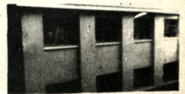
Vista del Hogar Quevedo cuya remodelación y modernización es una de las obras de la Junta de Desarrollo Social que preside la Primera Dama de la Nación.
