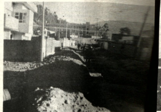
Obras comunales: alcantarillado, enl... co... pavimentación parques, canalización... as... urbanas.
